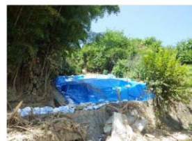
斜面下から崩壊地方向
