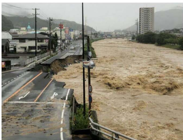
河川護岸崩壊により通行止め 【広島県広島市安芸区】(一般国道2号)
