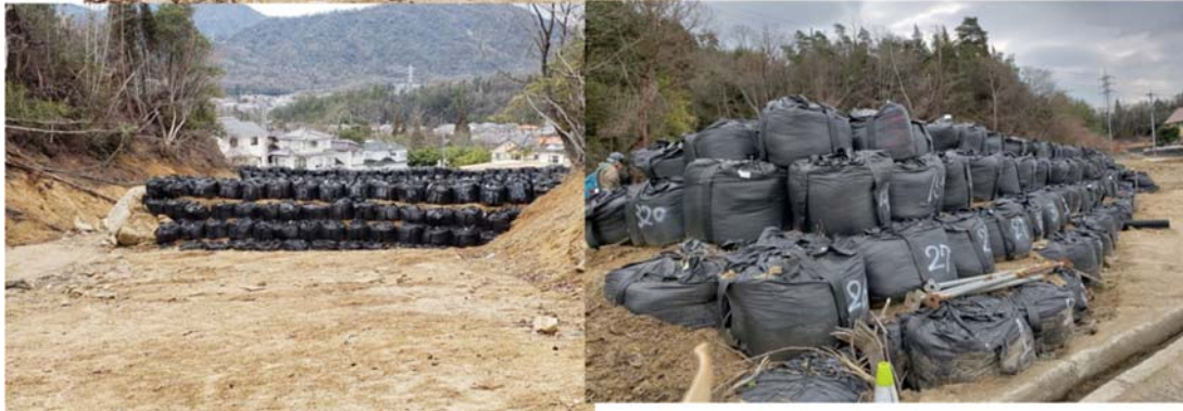
図 3-15 熊野町川角の応急復旧工事状況 (2)
