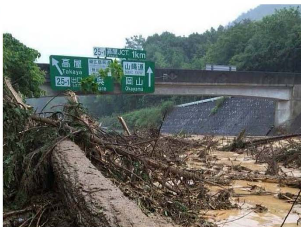
道路区域外からの土砂・流木が流入 【広島県東広島市】(山陽自動車道(高屋IC、JCT付近))
