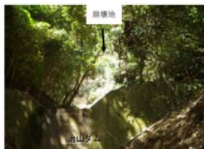
溪流上流部の崩壊と治山ダム
