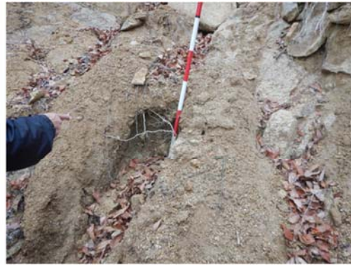
土石流流下部のバイピング痕跡
