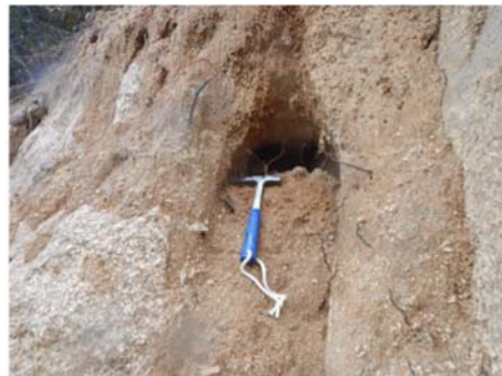
土石流流下上部で確認されたバイピング痕跡
