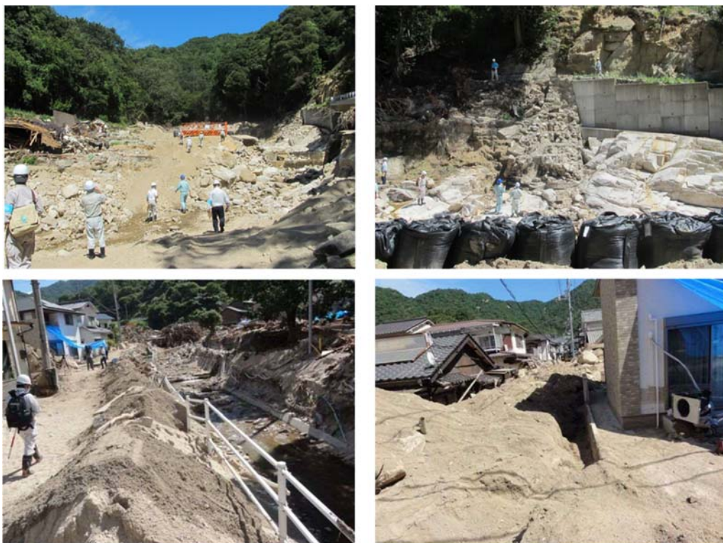
図 3-8 小屋浦地区天地川の石積砂防堰堤（昭和25年）と下流部の住宅被害調査
