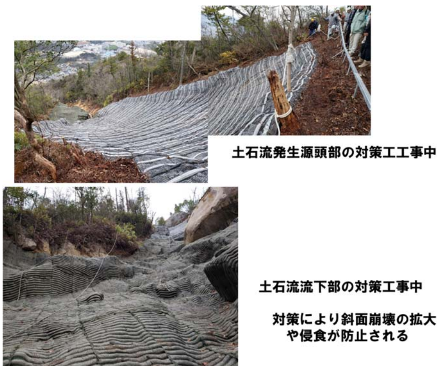
図 3-17 熊野町川角の本復旧工事状況 (2)
