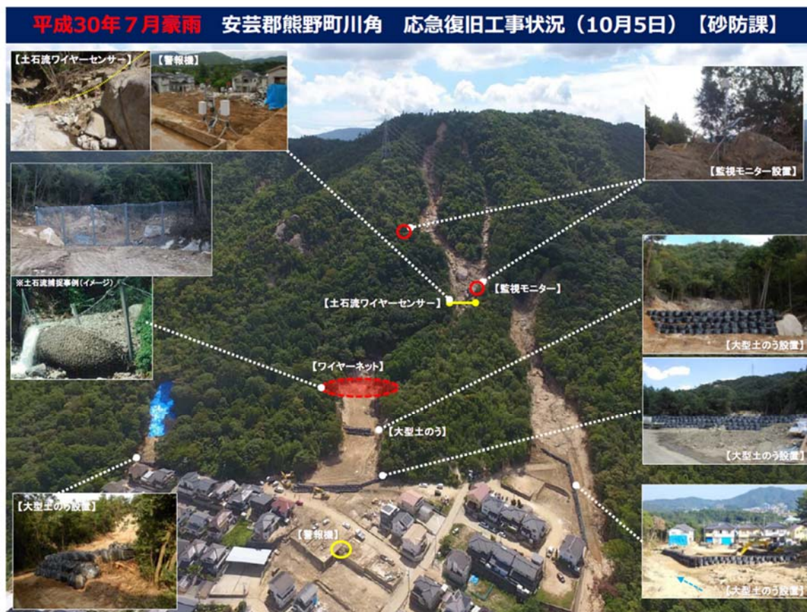
図 3-15 熊野町川角の応急復旧工事状況 (1)
