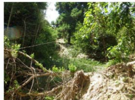
斜面右側の崩壊地
