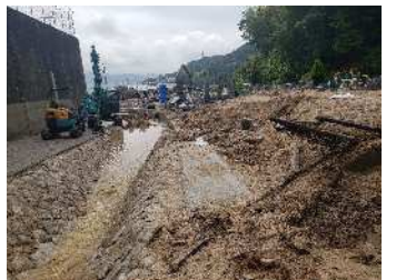
土石流の堆積開始 (基所1m堆積) 下流は住宅
