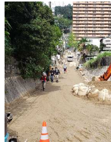
下方道路から見た上流状況
