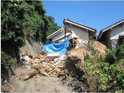
住宅背後の崖崩れ(鹿島町)
