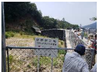
2020.8.4 可部東地区の堰堤の管理
