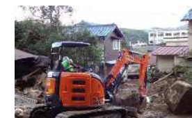
市道等に堆積した土砂の撤去
