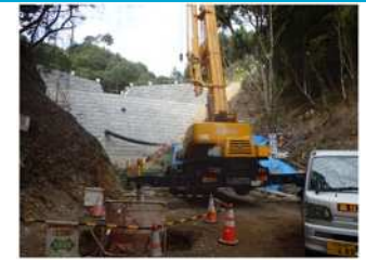
急峻かつ狭隘な現場
