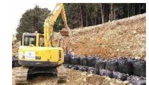
大型土のうの設置
