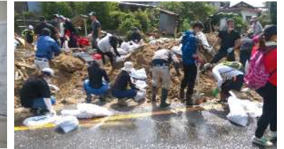
ボランティアによる土砂撤去作業状況
