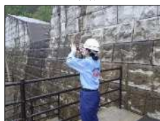
SMART SABO訓練(堰堤堤体確認)
