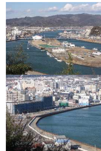
震災5年後旧北上川堤防嵩上げ工事中
