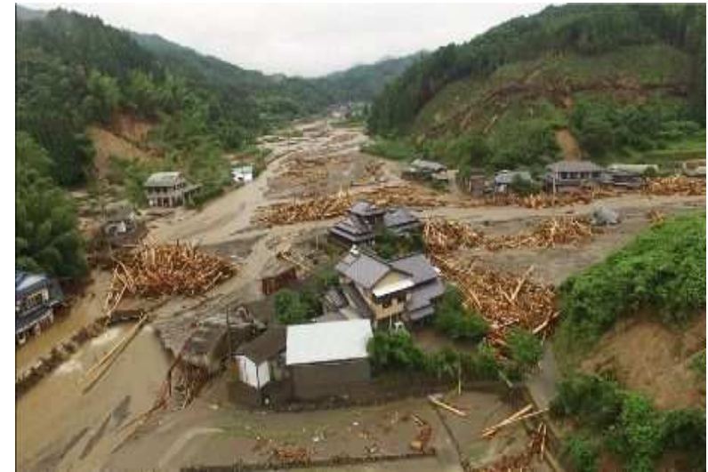
西日本豪雨災害 坂町 被災状況
