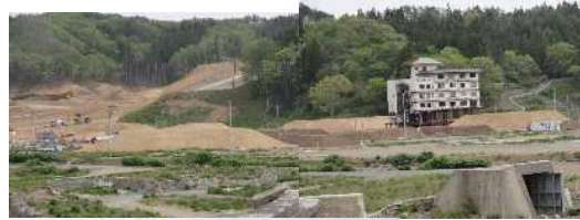
震災3年後 造成 工事始まる
