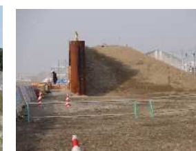
防潮堤の工事
