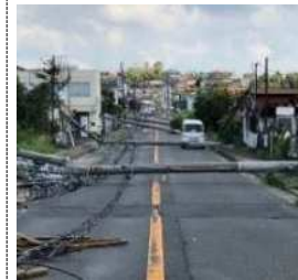
<電柱の倒壊による道路閉塞の事例>
