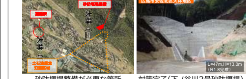
砂防堰堤整備が必要な箇所
