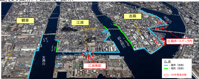
広島港海岸中央西地区高潮対策
