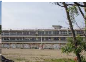
旧北上川左岸 湊小学校(1階)
