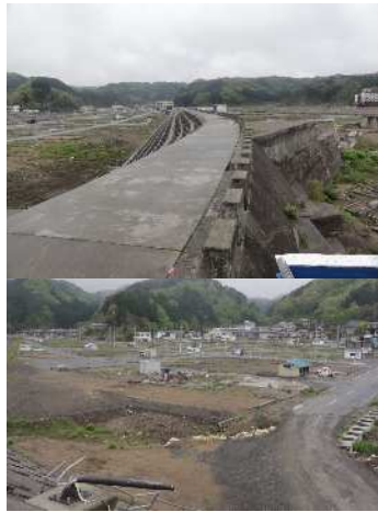
震災1年後 田老防潮堤と内部
