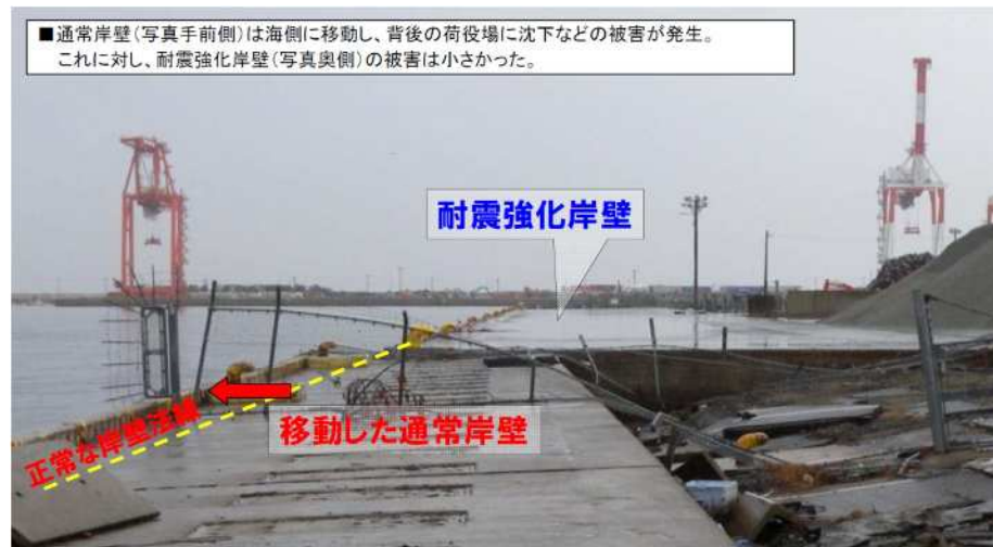
仙台塩釜港 仙台区(耐震強化岸壁)
