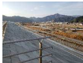
防潮堤の内側は空き地が目立つ
