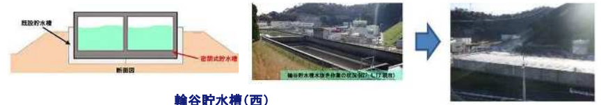
輪谷貯水槽(西)
