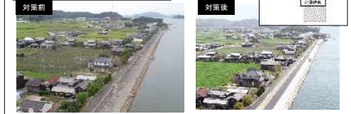
高潮対策が必要な箇所
