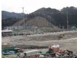
震災7年後 宅地の嵩上げと 学校建設始まる
