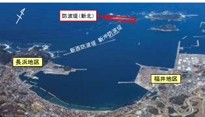
浜田港福井地区防波堤（新北）整備
