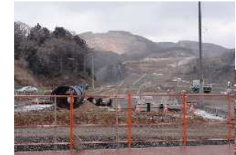
被災3年後、造成工事活発
