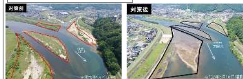
河道掘削・樹木伐採が必要な箇所
