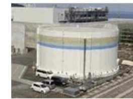
非常用過水タンク
