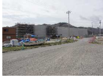
震災7年後 防潮堤工事
