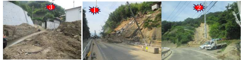
①被災直後; 土砂崩れ(通行止め 被災者孤立⇒救出)
