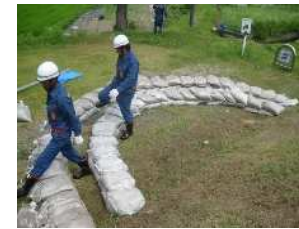
国：堤防漏水対策月の輪工法訓練
