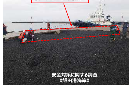
吸い出しによる陥没
