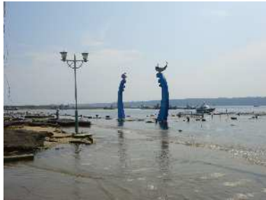
東北地方太平洋沖地震によって沈降した鮎川港 (宮城県石巻市)
