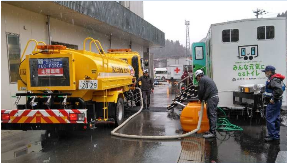
断水地域の仮設トイレへの給水作業
