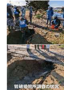
管破箇所調査の状況
