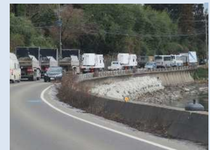
のと里山海道不通区間 国道429号渋滞状況(七尾市中島町) 24
